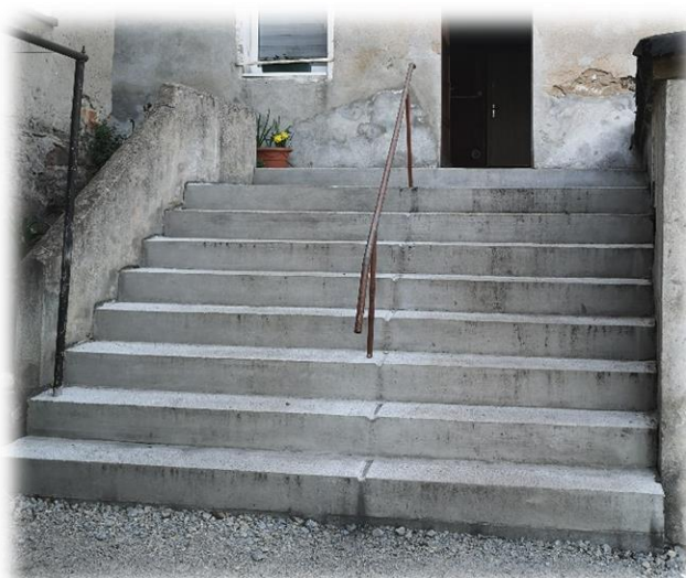
Schody przy ul. Strzeleckiej 29 w Toszku po remoncie
