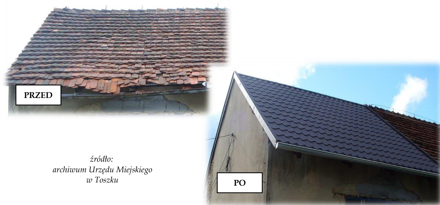
Naprawa dachu w Sarnowie przy ul. Wiejskiej 17
