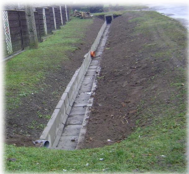
Rysunek 57 Konserwacja rowu w Kotliszowicach - zrealizowane w ramach Funduszu Sołeckiego w 2019 r.
