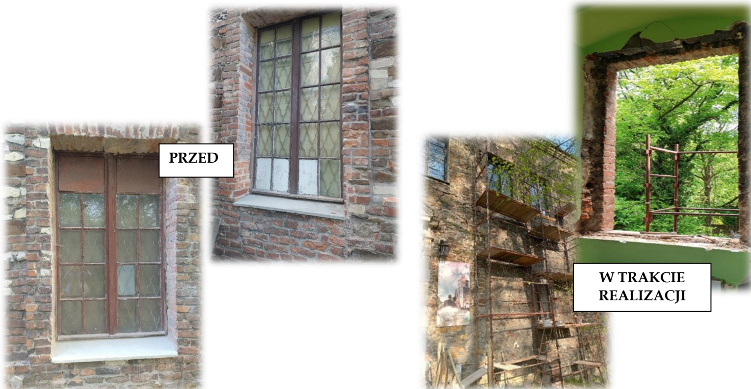
Wymiana stolarki okiennej w budynku bramnym Zamku w Toszku w 2025 r.
